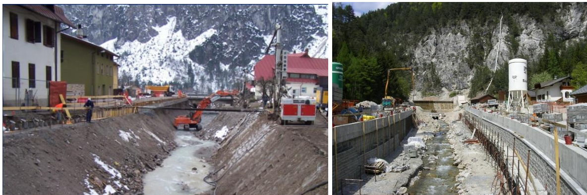
Figura 4.3 - Esempio di lavorazioni per la realizzazione di muri di micropali.
