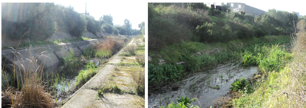
Figura 5.33 - Riu Cabu Abbas – a sinistra tratto rivestito in calcestruzzo; a destra tratto non rivestito.
