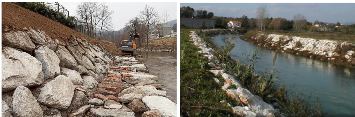
Figura 4.1 - Esempi di scogliera di media pezzatura a sistemazione delle sponde di progetto.
